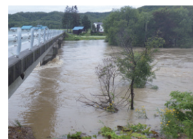
令和5年8月の大雨による河川の増水
